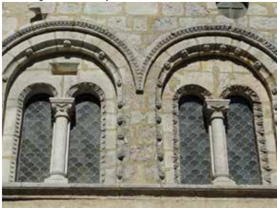
Baies des greniers de l'abbaye
